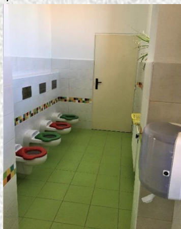
Nově zbudované sociální zařízení
